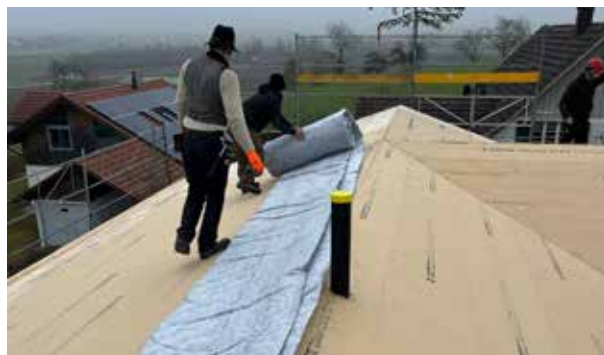
Déroutage de la bâche.
