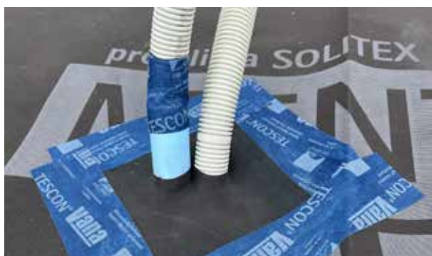
Les manchettes pro clima (adaptées au support) et le ruban adhésif universel TESCON VANA ont été utilisés pour réaliser l'étanchéité de gaines (ROFLEX pour jusqu'à 9 gaines) ...
