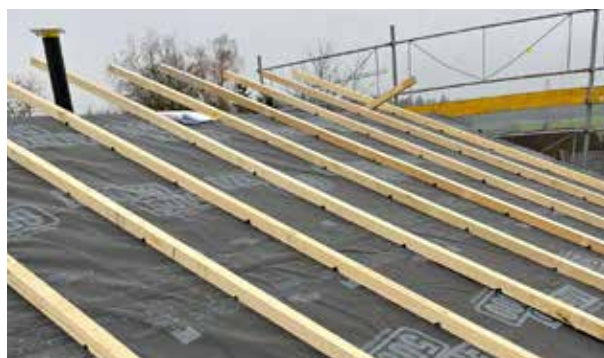
... et l'écran de sous-toiture SOLITEX MENTO 5000 connect.
