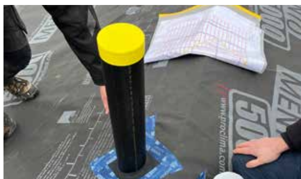
... et de tuyaux de ventilation (ROFLEX pour Ø 100 - 120 mm).
