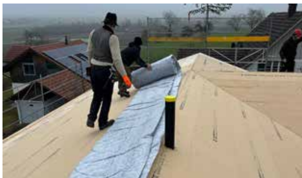
Déroutage de la bâche.
