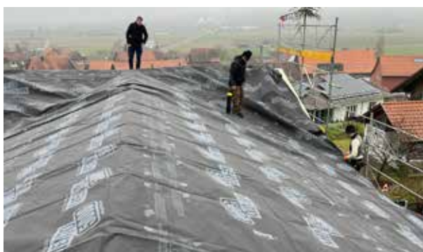
Bâche en SOLITEX MENTO 5000 connect mise en place.
