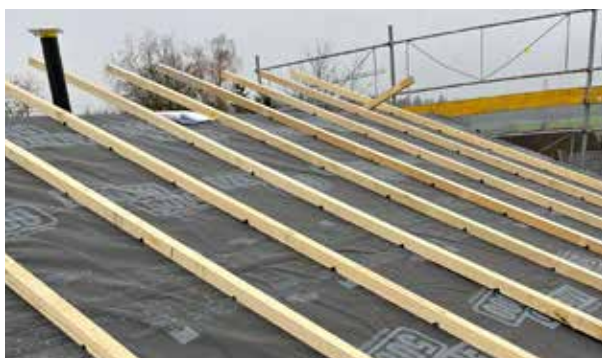
... et l'écran de sous-toiture SOLITEX MENTO 5000 connect.
