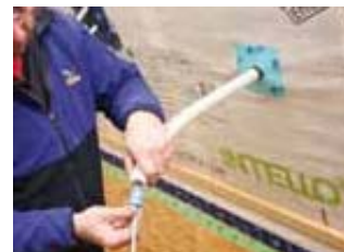
Figure 10: Mise en place du bouchon STOPPA
