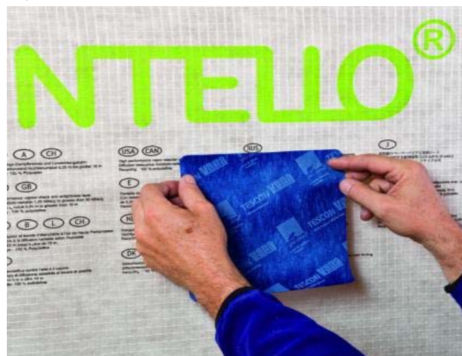
Figure 3: Colmatage des « trous » d'insufflation
