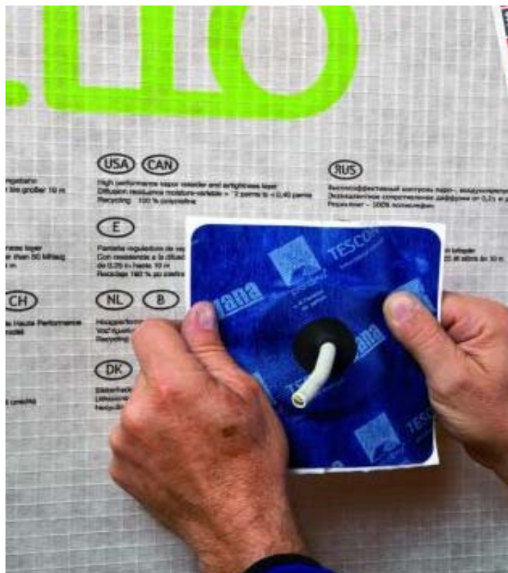
Figure 35: Collage de la manchette KAFLEX sur la membrane INTELLO / INTELLO PLUS
