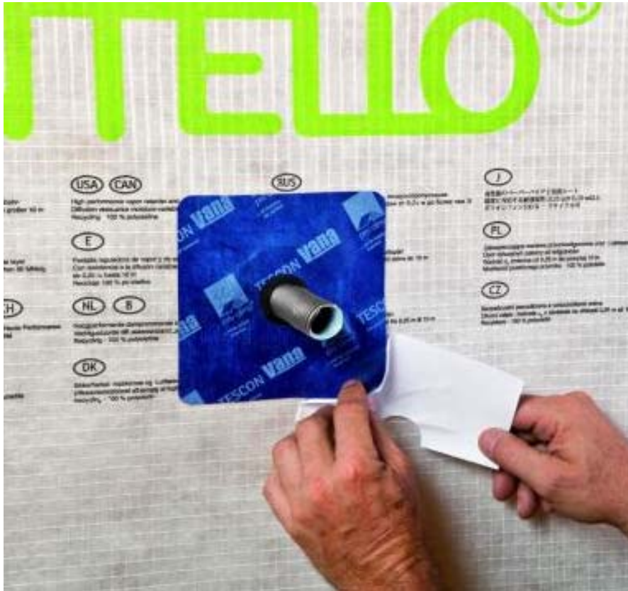
Figure 36: Mise en place de la manchette ROFLEX 20
