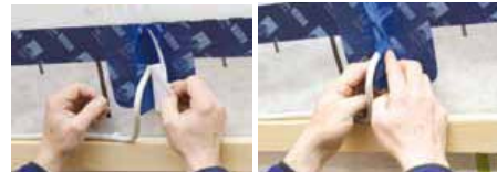
Figure 9: Retirer le papier transfert et maroufler
