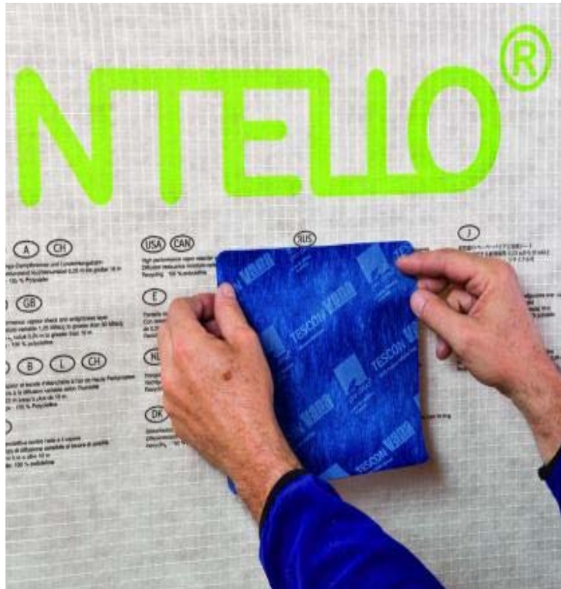
Figure 28: Colmatage des « trous » d'insufflation
