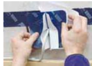
Figure 8: Mise en œuvre de la manchette Kaflex Post
