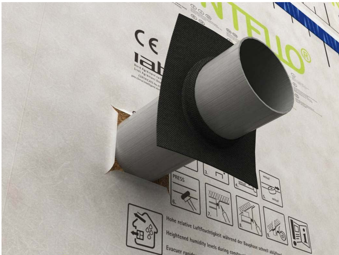
Figure 37: Mise en œuvre de la manchette ROFLEX sur le conduit
