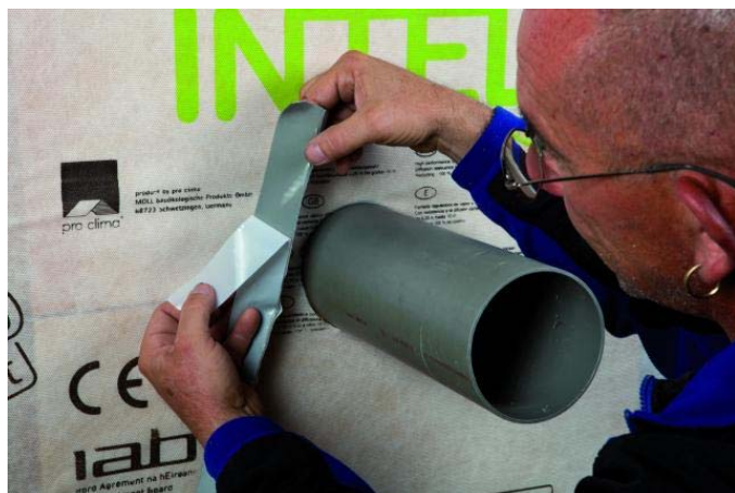
Figure 11: Collage de la manchette EXTOSEAL Magov au conduit
