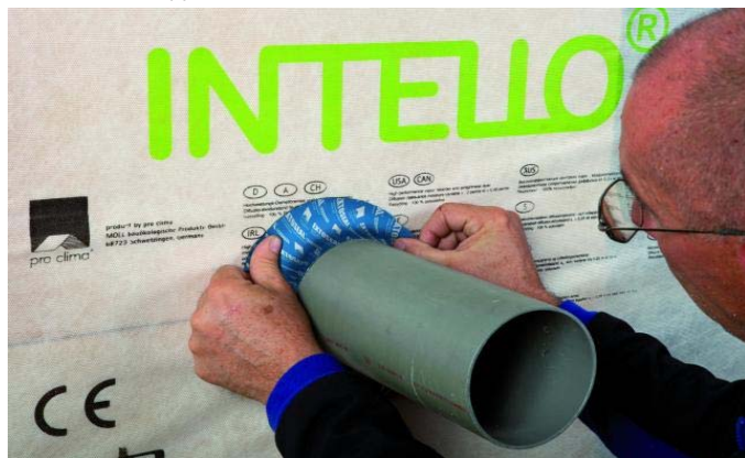
Figure 12: Collage de la manchette EXTOSEAL Magov sur la membrane INTELLO / INTELLO PLUS
