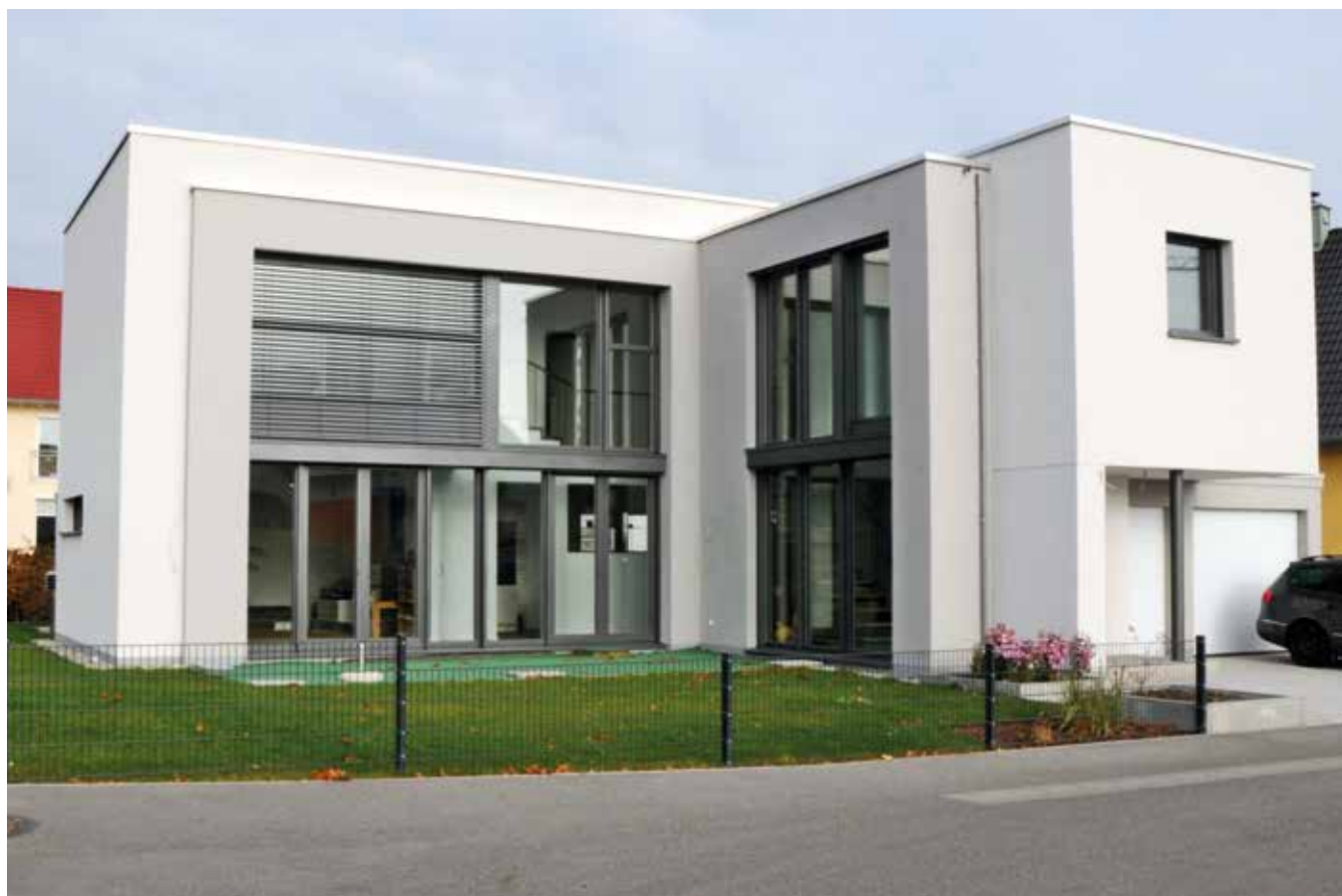
Lumière et énergie : le triple vitrage généreux, orienté au sud-ouest, permet une utilisation optimale des gains de chaleur. Des brise-soleil protègent l'intérieur de toute surchauffe.
