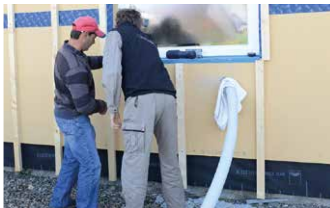
Tout le monde s'y met : durant l'atelier, Holger Merkel de pro clima montre à l'équipe de Tasuleasa Social les gestes essentiels pour réaliser l'étanchéité à l'air et au vent d'un bâtiment.
