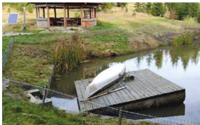
Développement durable et autarcie : l'installation d'épuration naturelle sur le site de Tasuleasa filtre et nettoie les eaux usées, avant de les déverser à nouveau dans le ruisseau.
