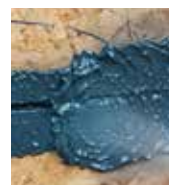
Rebouchage des joints et ssures jusqu'à 3 mm
