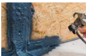
Raccord de murs à ossature bois à une dalle en béton
