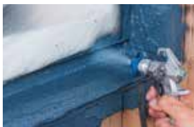
Raccord de fenêtres, y compris seconde couche drainante / dessous d'appui de fenêtre
