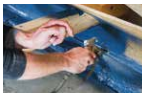
Raccord d'étanchéité en bas de toiture
