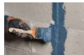
Rebouchage de ssures qu'à 20 mm
