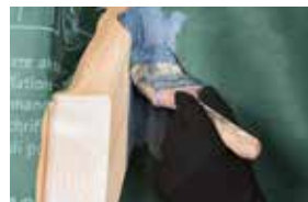
Raccord chevrons / noues avec AEROSANA VISCONN FIBRE et AEROSANA FLEECE
