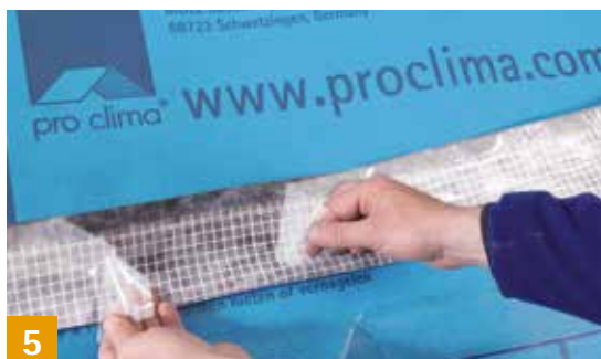
DUPLEX Ruban adhésif double face pour coller les joints aux extrémités des écrans et les raccords
