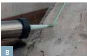
8 Raccord à des supports rugueux ou minéraux avec ORCON F
