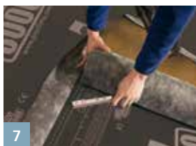
7 Surisolation 1:1 et écran de sous-toiture
