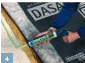
4 Raccord à une rive avec ORCON F
