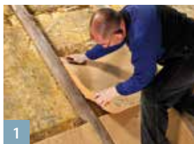
1 Remplir les caissons
