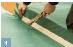
4 Fixation au chevron avec DASATOP FIX
