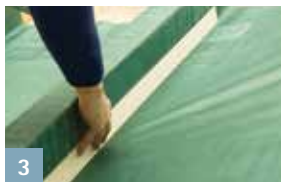
3 Pose de la membrane
