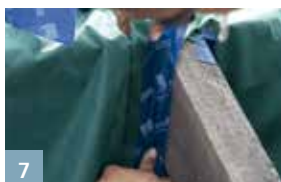
7 Raccord à des supports lisses non minéraux avec TESCON VANA
