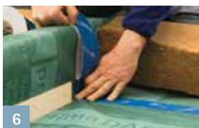
6 Collage des chevauchements avec TESCON VANA
