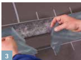
3 Réaliser le chevauchement et le collage des membranes
