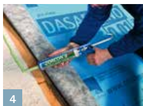
4 Raccord à une rive avec ORCON F
