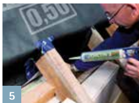
5 Raccord au pied droit de toiture
