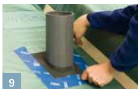
9 Raccord à des câbles et conduits avec KAFLEX ou ROFLEX
