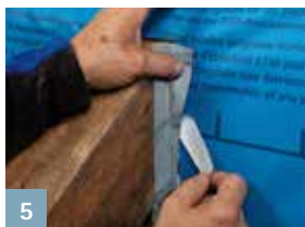
5 Raccord au pied droit de toiture avec TESCON FIX et ORCON F
