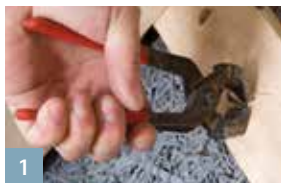
1 Préparation du support ( finition intérieure existante)
