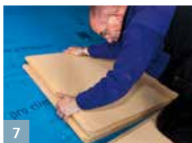
7 Solution 2:1 - plaques de plâtre cartonée et enduit sur panneaux légers en laine de bois
