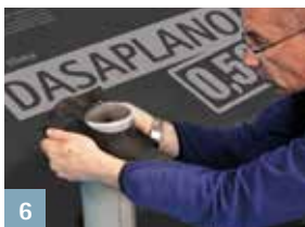
6 Raccord à des câbles et conduits avec ROFLEX
