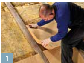
1 Remplir les caissons
