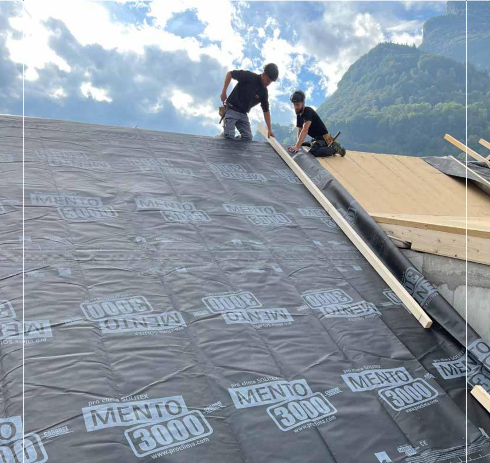
Des écrans de sous-toiture sur mesure pour votre toiture
