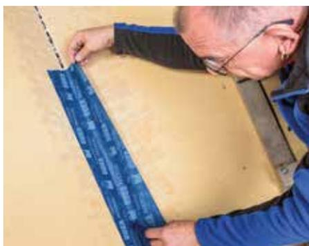
Sur les surfaces recouvertes de sous-couche, les rubans adhésifs de pro clima peuvent être collés sans délai d'attente.
