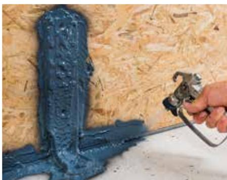
Pulvériser le film sur les équerres de fixation
