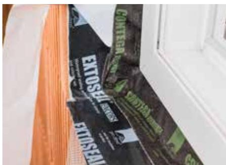
Dans les angles, collez le pli d'angle avec l'embrasure de façon étanche à l'air / à l'eau
