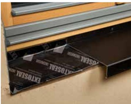
Raccord des menuiseries au nu extérieur du gros oeuvre maçonné.
