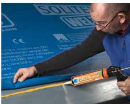
... pour le raccord des écrans de sous-toiture à l'extérieur
