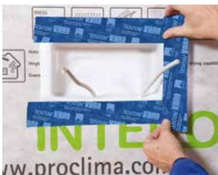
INSTAABOX, boîtier d'installation, laisse de la place pour les interrupteurs et les prises.
