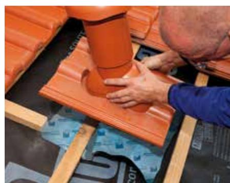
ROFLEX exto se colle facilement autour d'un conduit d'aération.
