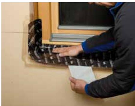
Utilisation comme protection sous la tablette de menuiserie (au niveau de l'appui de fenêtre).
