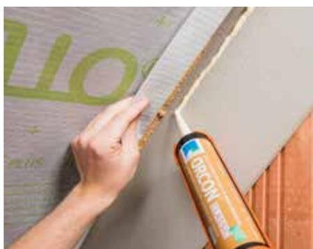
Colle de raccord de la membrane pour l'étanchéité à l'air intérieure
