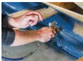
Raccord d'étanchéité en bas de toiture
