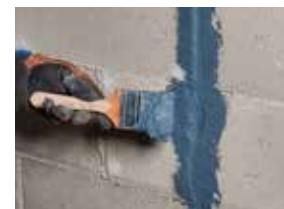
Rebouchage de fissures qu'à 20 mm
