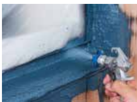
Raccord de fenêtres, y compris seconde couche drainante / dessous d'appui de fenêtre
