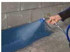
Réalisation de l'étanchéité de maçonneries apparentes ou d'enduits défectueux
